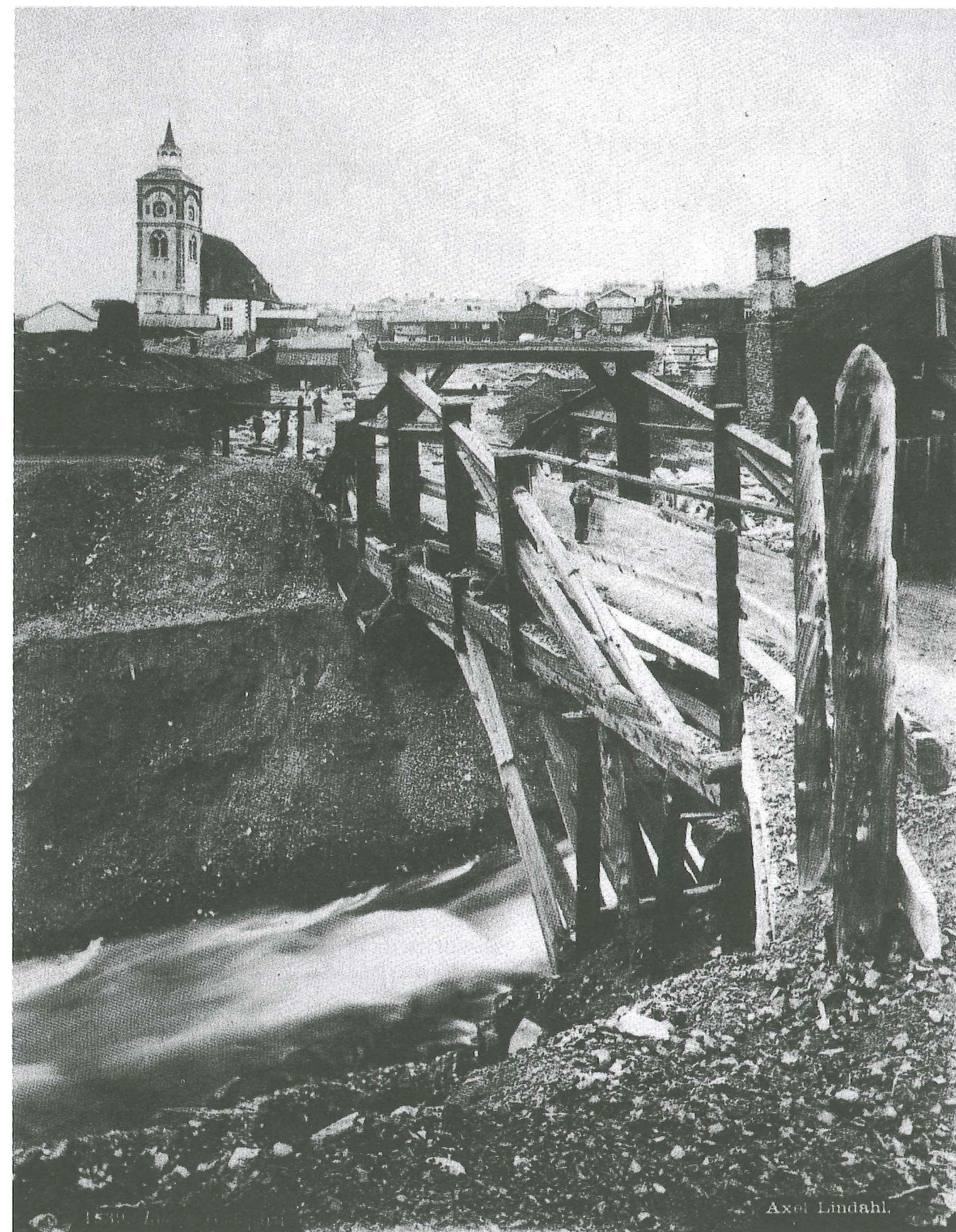
Dette bildet er det einaste kjente som syner litt av den gamle smeltehytta frå 1840. I den nedste delen av hytta, som her hadde valma tak (og liggande panel), låg garrhytta. Vi ser pipa til garromnen utanfor hytteveggen. Heilt til h. ser vi litt av maskinhuset. Like nedanfor hyttebygningen ser vi litt av røstet og takåsane av eit hus. Utan tvil er det det nye maskinhuset som blir tømra opp her. Etterpå vart tømmerkassen merka ned og lagt opp att på muren ved elva. Legg merke til konstruksjonen av Slæggbrua. Stativet til hyttklokka var også anleis den gongen. «Stuppulen» ragar høgt over husa omkring. Stativet var truleg ein halv gong høgare enn no. Det som står i dag vart bygd i 1890-åra.
