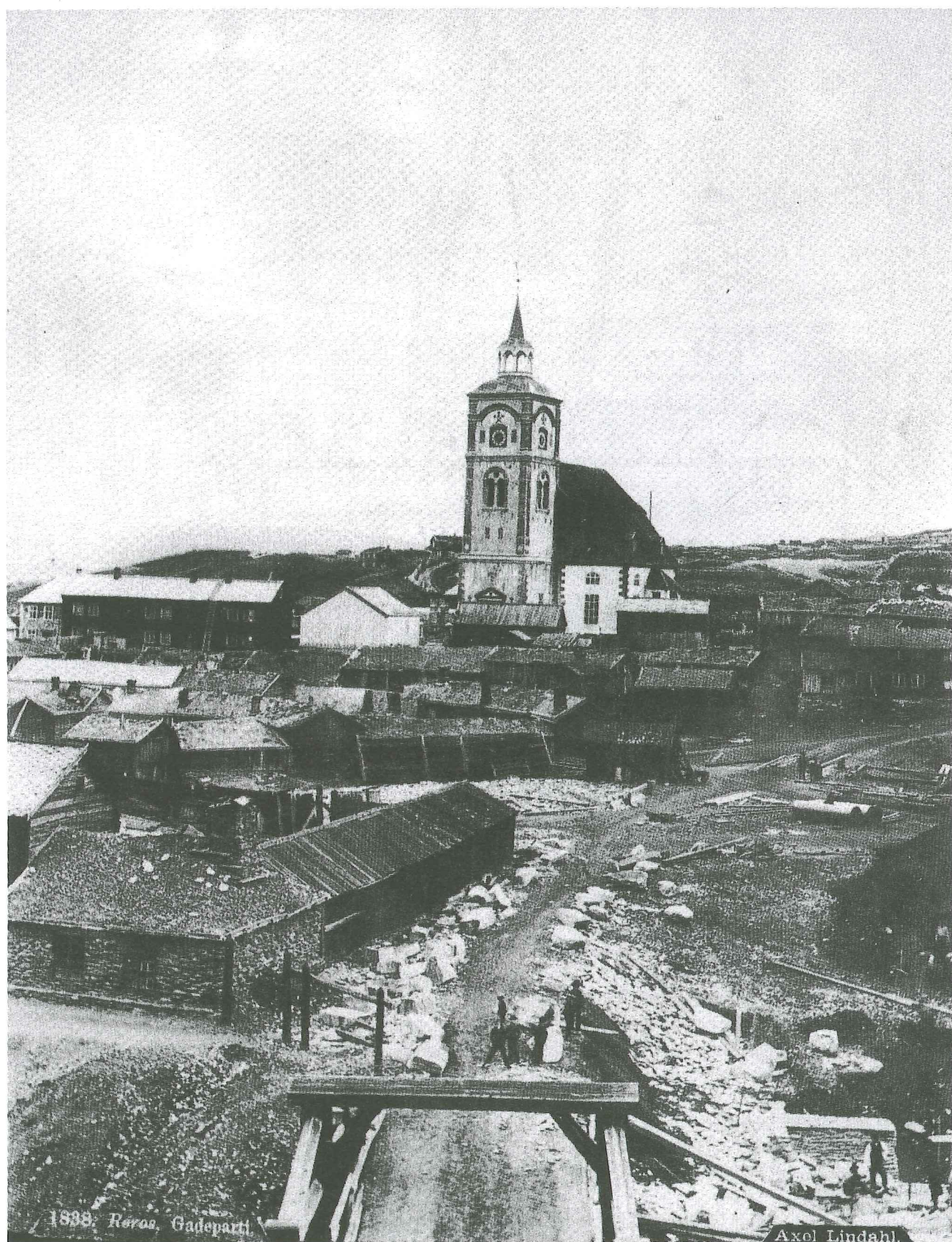
To glimt av malmplassen 1878. Her er mannskap i gang med muring av fundamentet under det nye maskinhuset. Det ligg murstein langs vegen fram mot Sleggbrua. Det står att nokre få meter, så er også grøfta for turbinledningen framme ved maskinhuset. Det ligg tre rørlengder til ledningen ute på malmplassen. Heilt nedst på malmplassen bak uthusa til gårdane i Mørkstugata ligg det òg ei steinvelte, - her var det fast opplagsplass for murstein til hyttomnane. I skuret med telt-tak bak steinvelta vart det lagra hjulstokkar. Like ovafor står det ei malm- og steinvekt.
