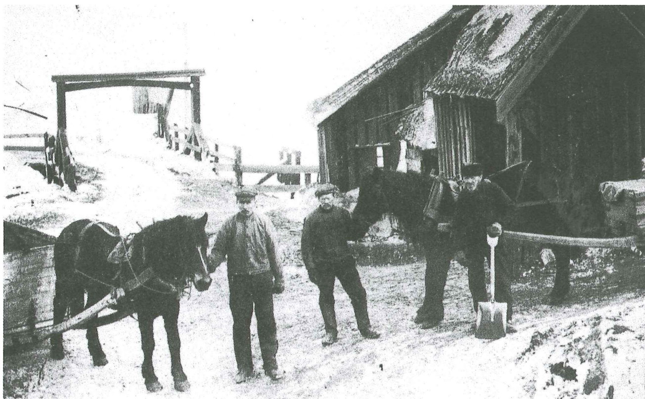
Arbeidsfolk med hestar. Ved øvre enden av smeltehytta, mot Sagbrua. (Ant. 1907-08).
